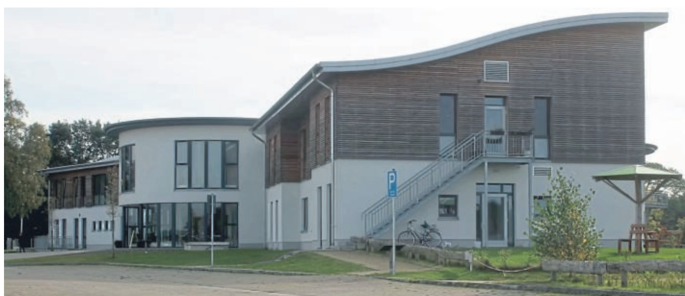
Die Gebäudeform soll an einen Kranich erinnern. 2014 ist das Europäische Fachzentrum für Moor und Klima (EFMK) „Moorwelten“ in Ströhen eröffnet worden.
