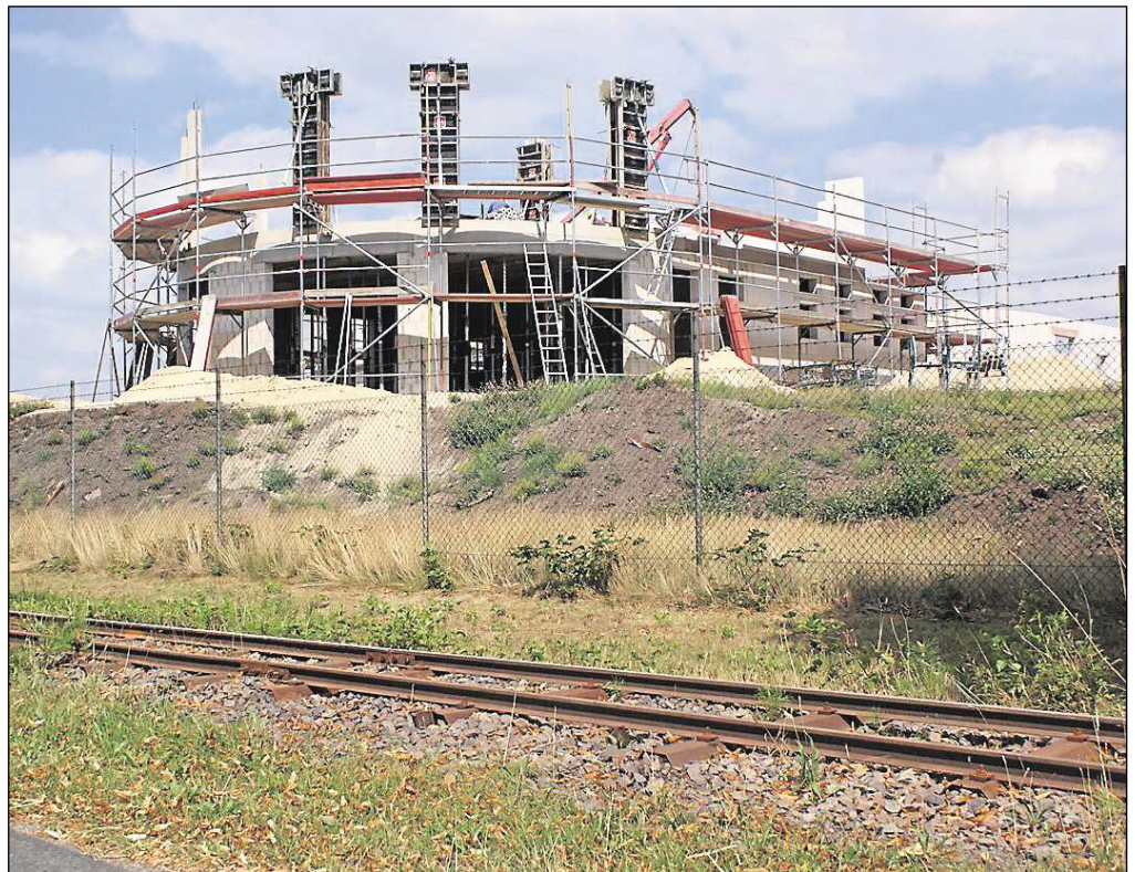
Die Fahrt mit der Moorbahn führt unter anderem vorbei an der Baustelle des Europäischen Fachzentrums Moor und Klima (EFMK). ■ Foto: Brauns-Bömermann
