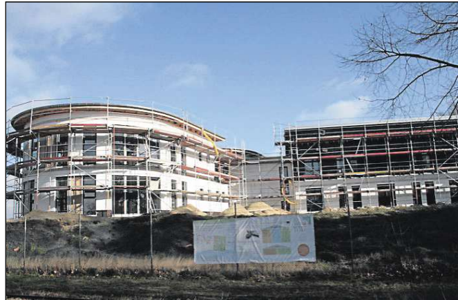
Die Bauarbeiten am EFMK in Ströhen liegen im Zeitplan und im Kostenrahmen. Am 31. Oktober ist Einweihung. ■ Foto: Benker
